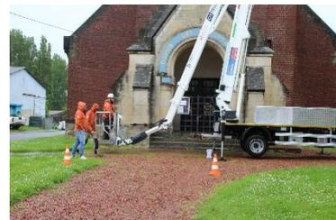
*trop important de l'intervention nous avons demandé la location d'une nacelle plus haute pour la dépose de la croix et du coq et effectuer les travaux de sécurisation (protection de l'édifice : mérule).*
